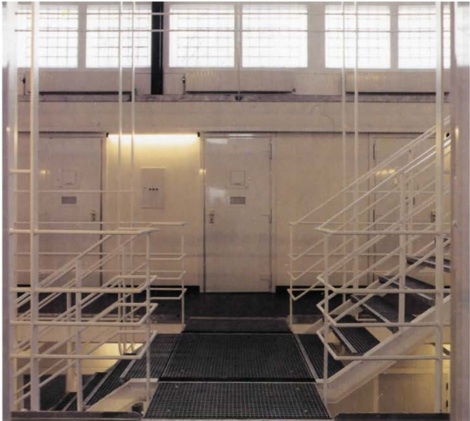
Esserheem de nieuwe woon- afdeling, tweede verdieping zuidzijde Esserheem new block, second floor, south facade
